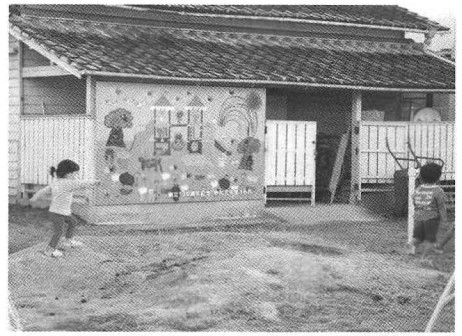
図4 取付け完成後
